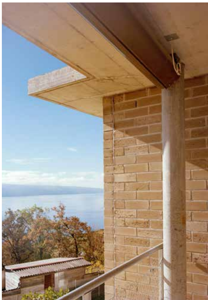
Les murs en briques de terre compactée contribuent à caractériser l'esprit du lieu.
