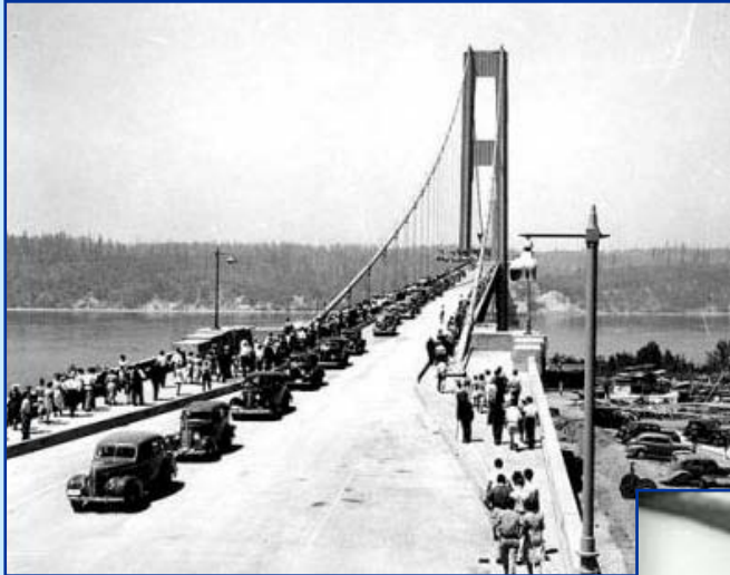
Pont de Tocama (USA, 1940)
