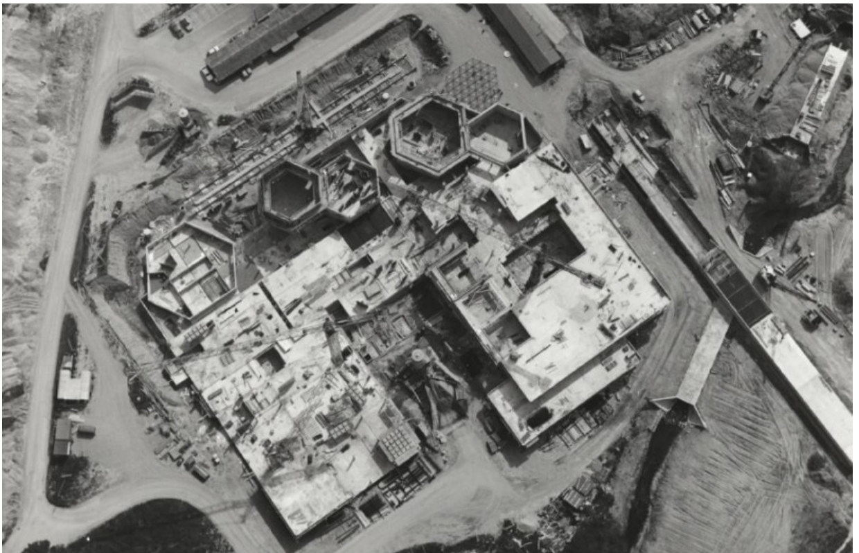
Vue aérienne de la construction du bâtiment Internef. web : 40 d'umil à Dorigny
