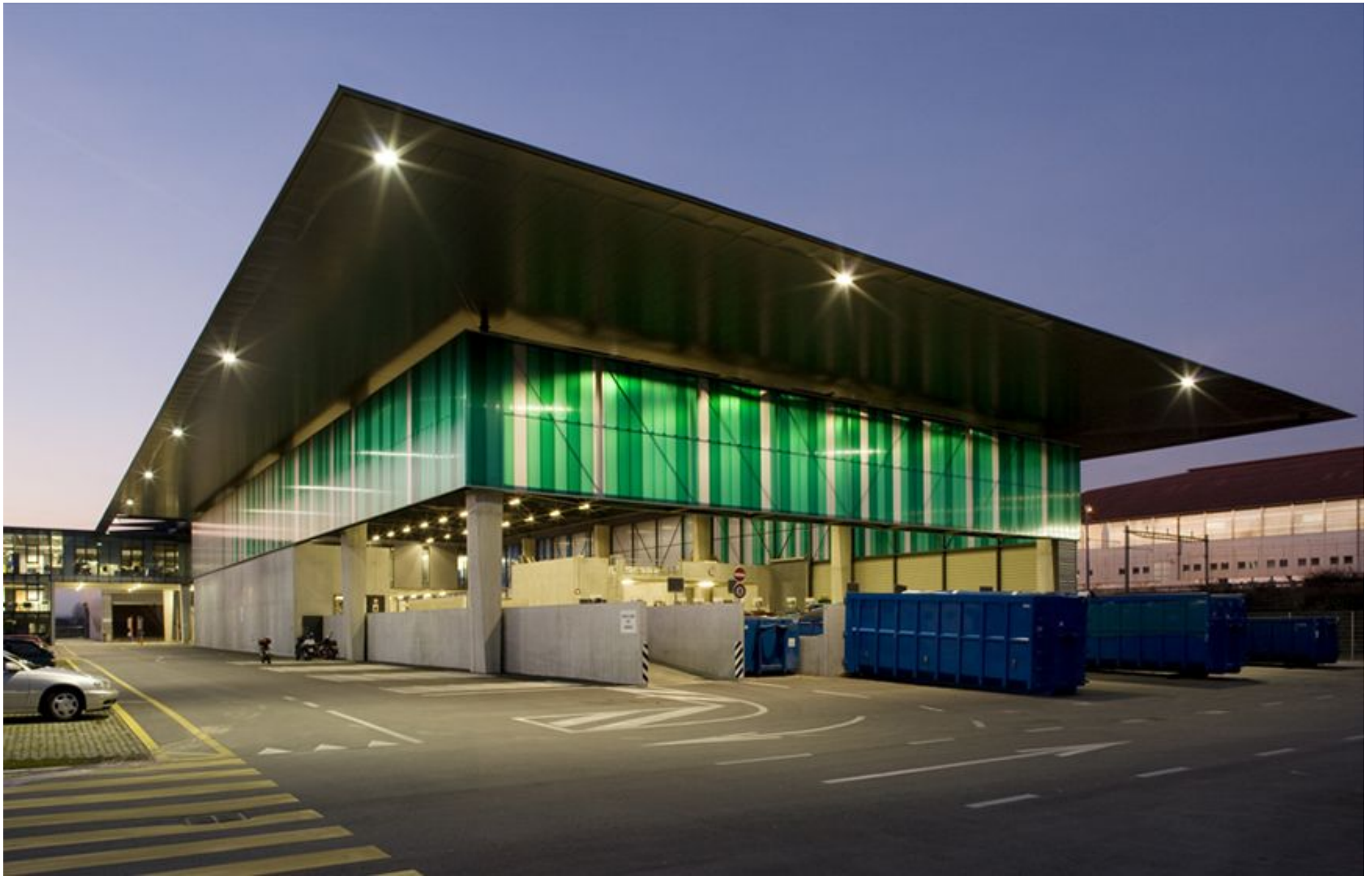
Ferrari Architectes Déchetterie de Malley, 2006-2010
